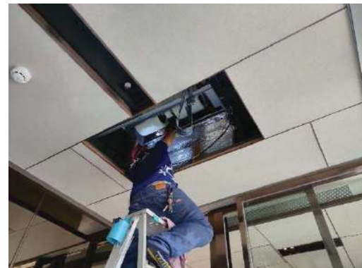
เจ้าหน้าที่ทำความสะอาดเครื่องปรับอากาศ
